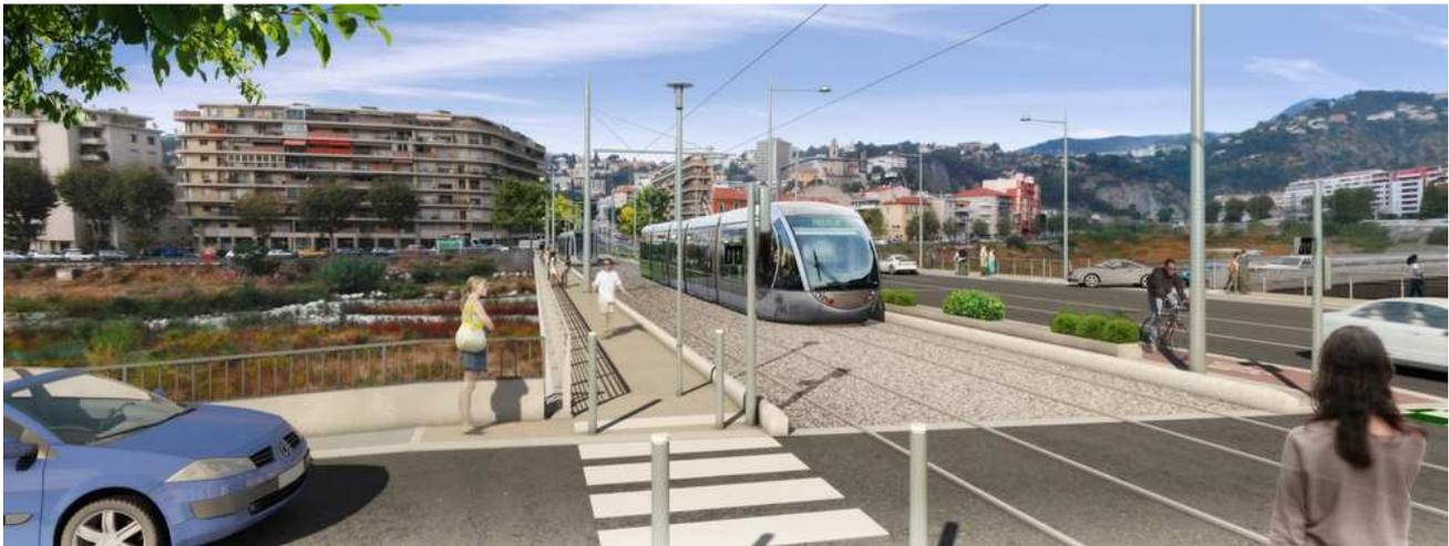
**Le nouveau Pont, implanté dans "l'ombre hydraulique" de l'ouvrage existant, n'aura aucune incidence sur le débordement du Paillon lors des épisodes orageux** car les piles (les appuis) du pont, sont alignées avec ceux du pont Coty, dans le sens de l'écoulement, et que le gabarit de l'ouvrage, la hauteur libre sous le tablier du pont, est identique. Ces dispositions ont été établies en concertation avec les services de l'Etat assumant la Police de l'Eau.
